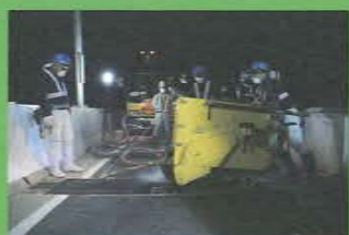
ダイヤモンドワイヤーを 設置する溝を作成
