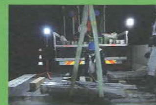
4tユニック車で撤去
